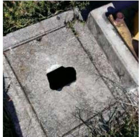
Foto 1 Tanquilla rota por la cual sustrajeron el cableado en la Unidad de Producción Animal ULA el 18/02/2017
