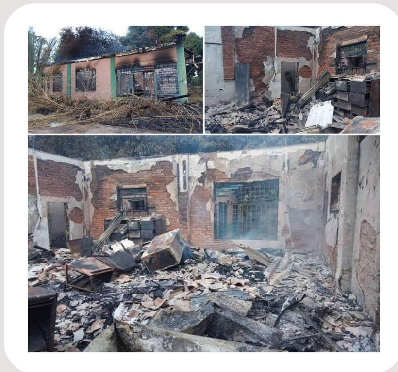
Incendio del Mini Auditorio del Núcleo de Bolívar de la UDO. Fuente: Anónima.
